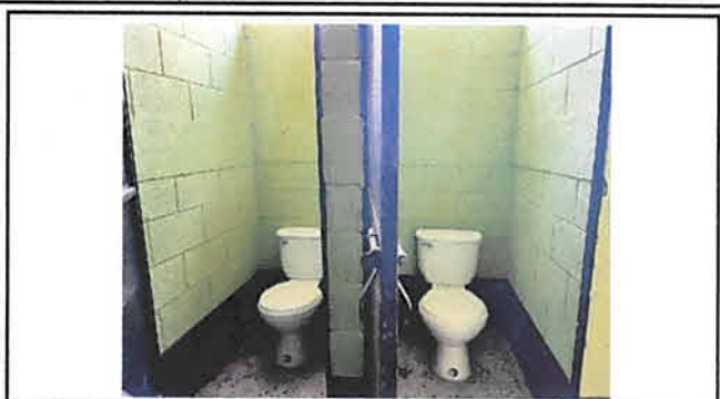
Foto 2: Trabajo finalizado cambio de accesorios a los servicios sanitarios.
