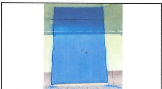
Foto 4: Trabajo finalizado mantenimiento a portones interiores de las aulas.
