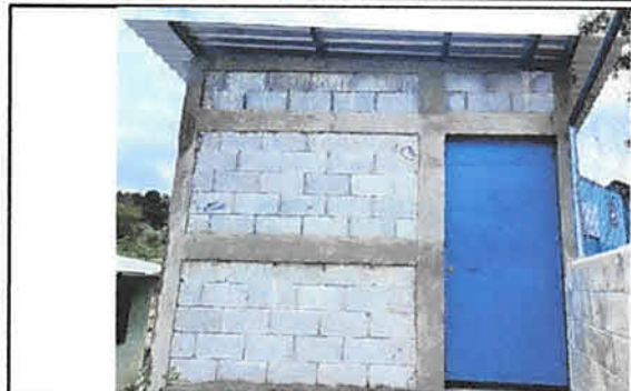
Foto1: Trabajo finalizado reparación del área de cocina, techo de lamina con estructuras de metal, con una puerta y una ventana.
