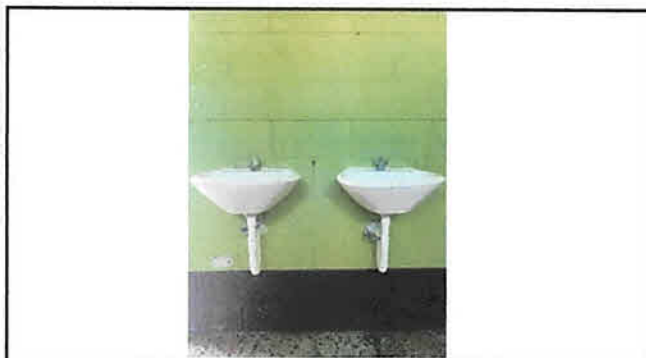
Foto 3: Trabajo finalizado cambio de accesorios lavamanos.
