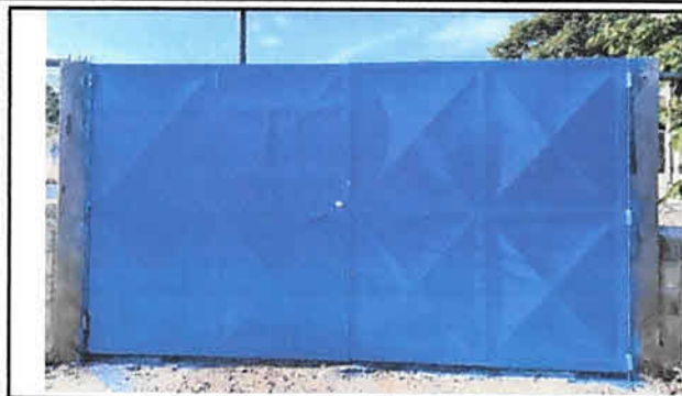
Foto1: Trabajo finalizado mantenimiento al porton principal.
